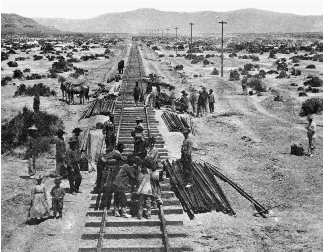
Construcción del ferrocarril transcontinental en 1868. (California State Railroad Museum Library)
